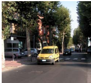
Via Piave dopo i lavori di asfaltatura
