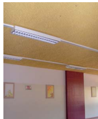
Soffitto insonorizzato nel refettorio delle Scuole Elementari Moruzzi
