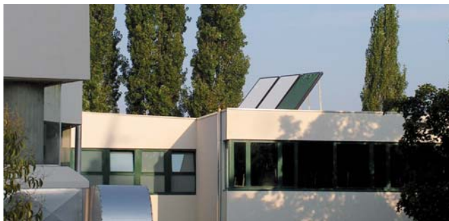
I pannelli solari montati sul tetto delle Scuole elementari XXV Aprile
