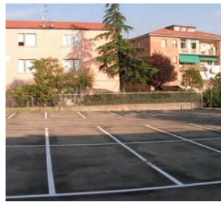
Il parcheggio realizzato in via Morandi a Ceretolo
