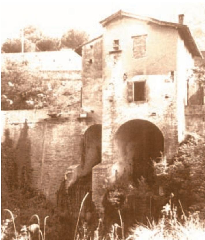
La "Scaletta". La bocca di sinistra è un'anormale paratoia per regolare i livelli dell'acqua e per la pulizia automatica del canale. La bocca di destra serve invece a far defluire in Reno i lastroni di ghiaccio e di blocchi di nevacchio che si formano (o, almeno, si formavano) d'inverno (Foto Pier Luigi Chierici)
