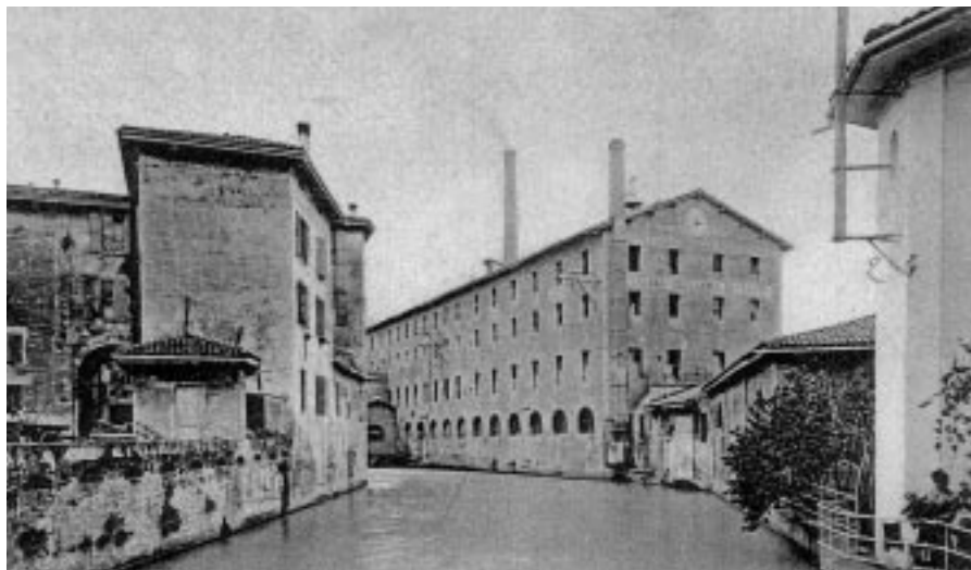
L'antico Mulino della Canonica ed il Canapificio e Filanda, in una immagine di G. Mengoli (fine sec. XIX). I due stabilimenti utilizzano, come forza motrice, il primo salto d'acqua del Canale che, già da secoli, muoveva il primo "polo industriale" di Casalecchio, con una cartiera, un battiferro ed altre attività lavorative, (Collezione Pio Chierici).
