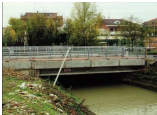
Il nuovo ponte che da Via Bastia va in zona Filanda.
