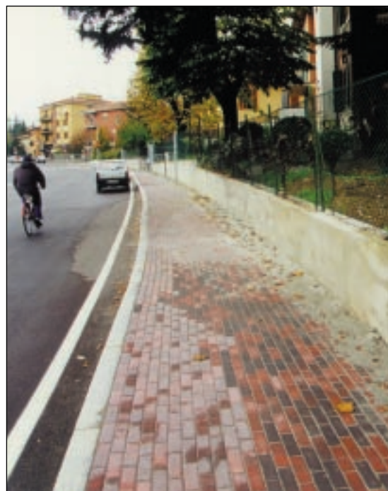
Nuovi marciapiedi sulla Via Bazzanese all'altezza della Chiesa di S. Lucia.
