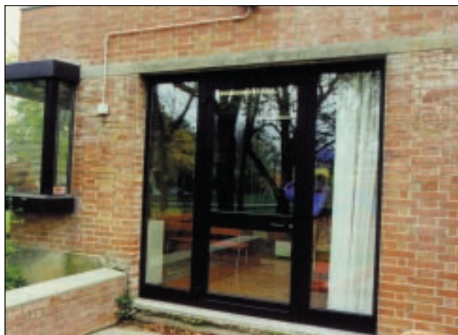
Nuovi infissi e marciapiedi alle scuole Dozza a Ceretolo.
