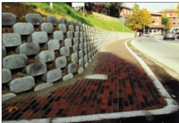
Nuovi marciapiedi in Via Porrettana di fronte al Parco Rodari.
