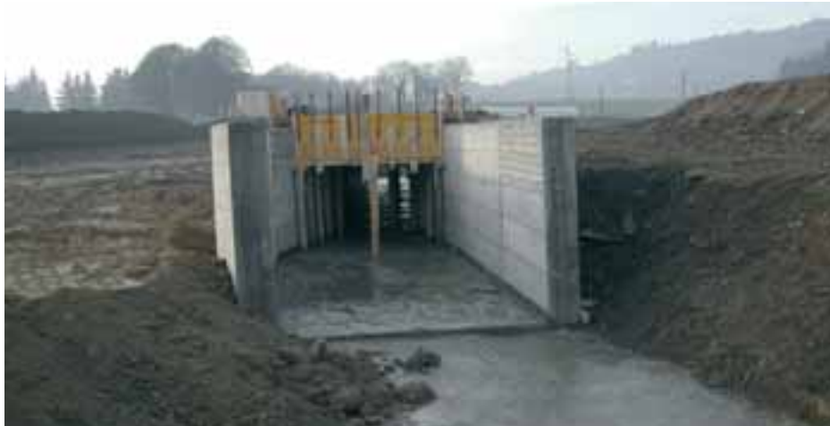
Opere idrauliche sul Rio Bolsenda: Manufatto della cassa di espansione (regolazione afflusso delle acque)
