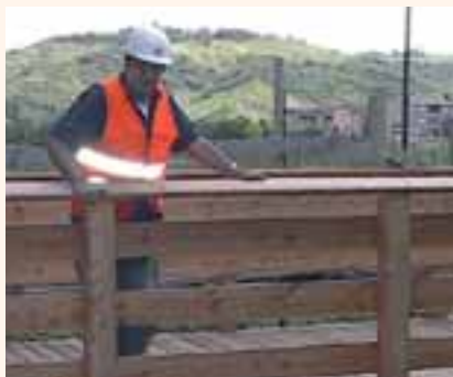
Passerella in legno montata sul Rio Bolsenda dai volontari per la Protezione Civile (Gruppo Alpini di Casalecchio). Sopralluogo Assessore LL.PP. Roberto Mignani
