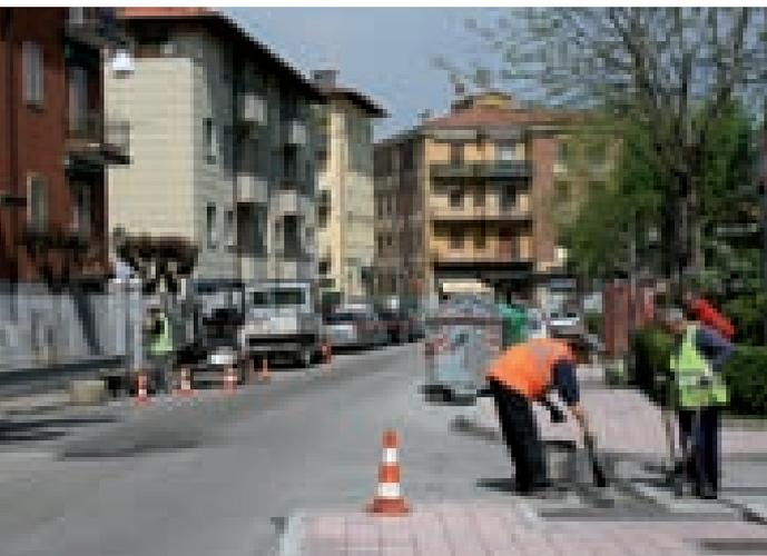
La prima fase dei lavori di riqualificazione di via Manzoni è terminata. Tutto il marciapiede del lato sinistro della strada è stato allargato e sono state costruite le penisole a protezione degli attraversamenti pedonali e delle fermate dell'autobus.
