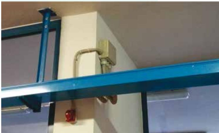
All'interno degli spazi comuni dell'edificio sono state realizzate le alimentazioni elettriche di forza motrice e le linee fonia-dati utili all'installazione di moduli wi-fi distribuiti.
