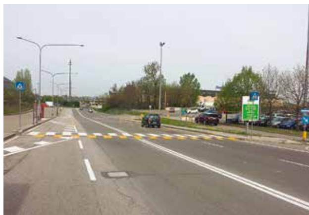
IL RECENTE INTERVENTO DI ABBATTIMENTO DELLE BARRIERE ARCHITETTONICHE IN VIA DE CURTIS PRESSO IL CAPOLINEA DELLA LINEA 85
