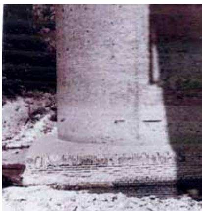
VERIFICA DELLO STATO DEI PILONI DEL PONTE PER PROGETTARE DELLE OPERE DI SOSTEGNO, FOTO DI CESARE CHIERICI, SANZA DATA (ATTORNO AL 1970). SULLA BASE DI QUESTA DOCUMENTAZIONE (DELLA QUALE PUBBLICHIAMO UNA UNICA IMMAGINE) IL CONSORZIO DELLA CHIUSSA E DEL CANALE DI RENO PRESENTÒ UN PROGETTO PER LA COSTRUZIONE DI TRE BRIGLIE, ACCOLTO PERÒ SOLO IN PARTE.
